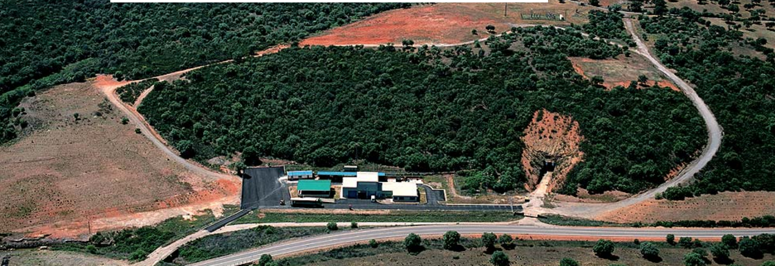
Vista General de las instalaciones denominadas Las Cuevas (Almadén)
